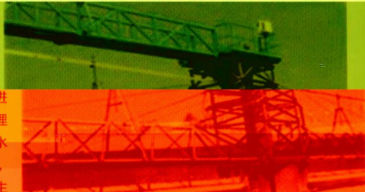
其它的吸泥机相比，可使二沉池污泥浓度提高20%~30%，从而提高生物反应池的污泥浓度，大幅度提高生化反应效率和污泥脱水效率，减小池容，降低工程造价，同时也减少了日常的运行耗电费用。与该设备相对应的周边进水周边出水圆周型沉淀池。本沉淀池水力条件好，表面负荷与一般幅流沉淀池相比可提高1~3倍；同时排泥泥质新鲜，可减少曝气量，节能。
